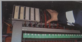
Ein Teil der elektronischen Steuerung der alten Schwebefähre
