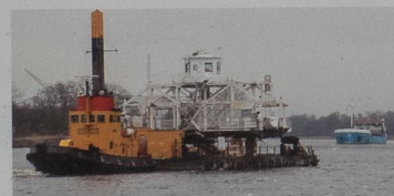
Abtransport zur Inspektion, 16.03.2016
