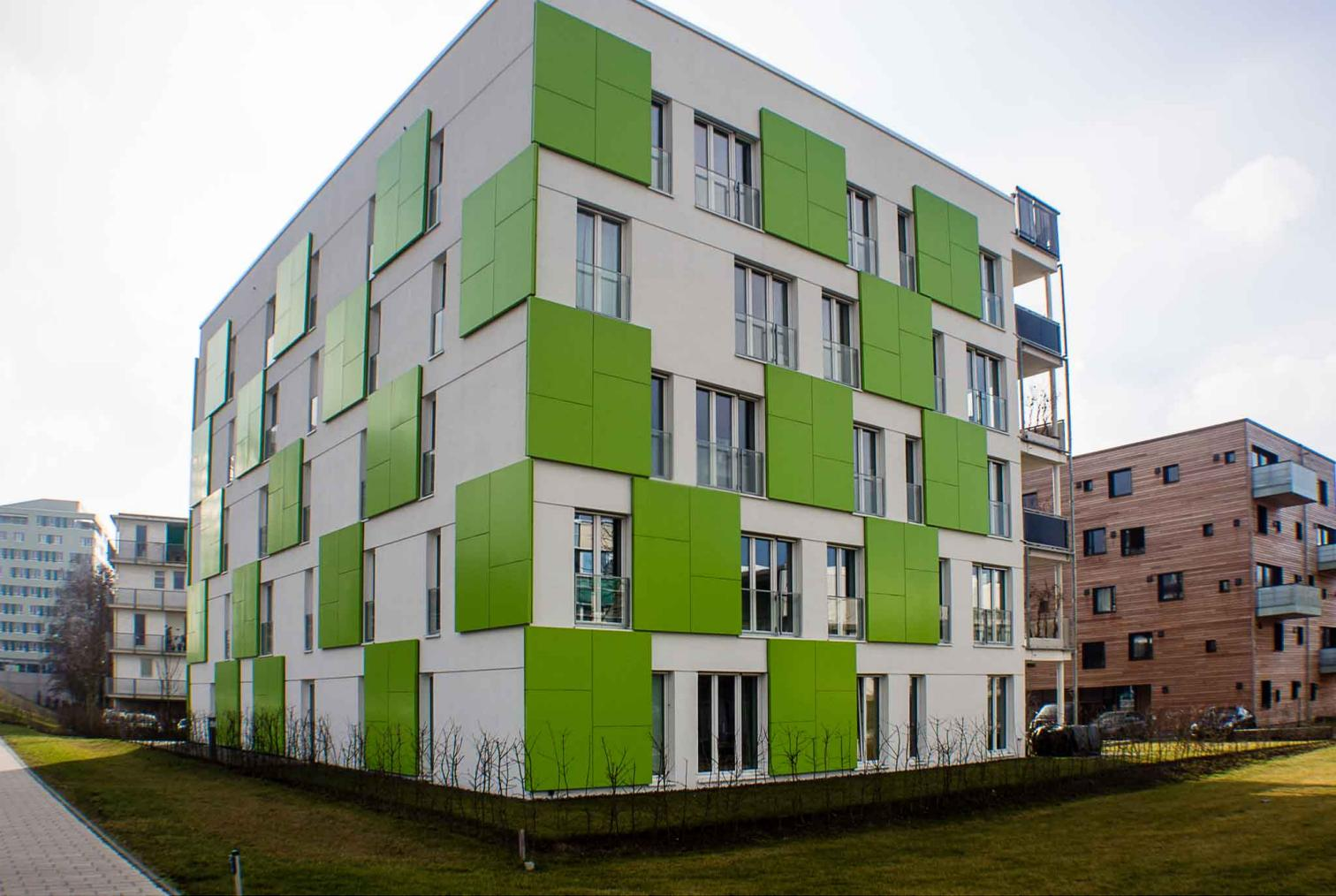
An der Außenhülle finden sich außerdem Photovoltaik-Flächen zur Umwandlung der Sonnenlicht-Energie in elektrische Energie und auf dem Dach Solarthermie-Flächen zur Umwandlung der Sonnenenergie in Wärmeenergie. Fassade und Dach sind bei "Smart ist Grün" also aktiver Teil eines ausgeklügelten hautechnischen Konzepts. Sie erzeugen durch innovative Technologien Energie, die direkt im Haus verbraucht wird. Gleichzeitig sind sie Teil des architektonischen Konzepts.
