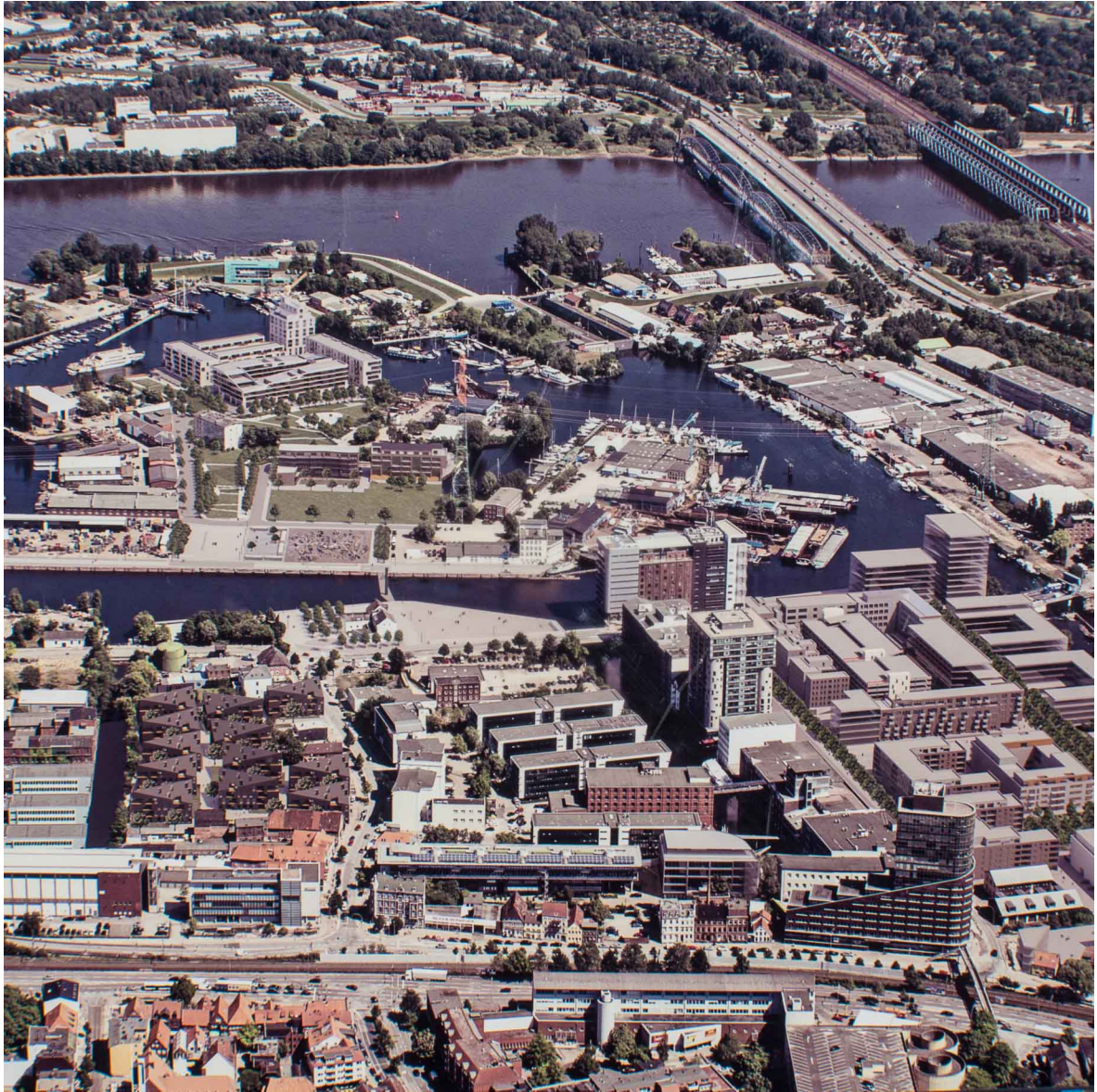
Planbild "Maritimes Harburg" nach kompletter Fertigstellung
